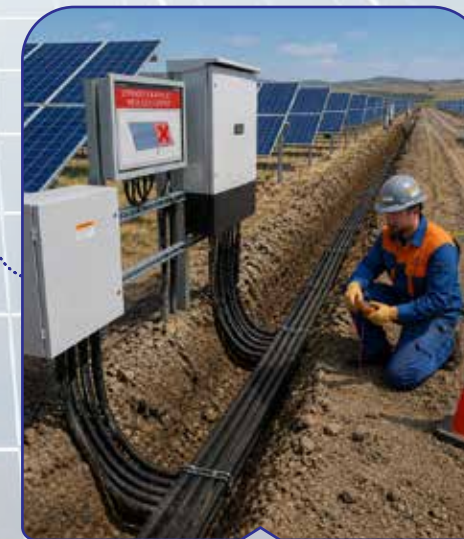
کابل‌کشی، نصب تابلو و تجهیزات حفاظتی
