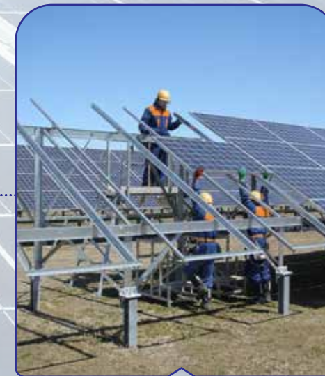
اجرای استراکچر و نصب پنل
