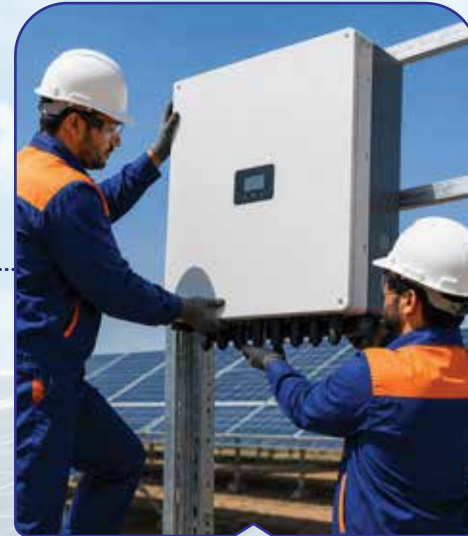
نصب اینورتر و راه‌اندازی سیستم
